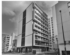
R4年3月完成 鉄筋コンクリート造10階 全104室 宮城県仙台市宮城野区小田原ノ町100 契約年数1年~2年定期建物賃貸借契約
